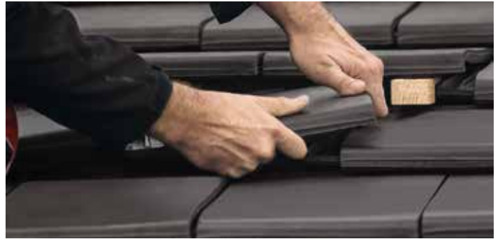
Sturmfix 2.0 macht den Austausch z.B. beschädigter Dachziegel kinderleicht.
